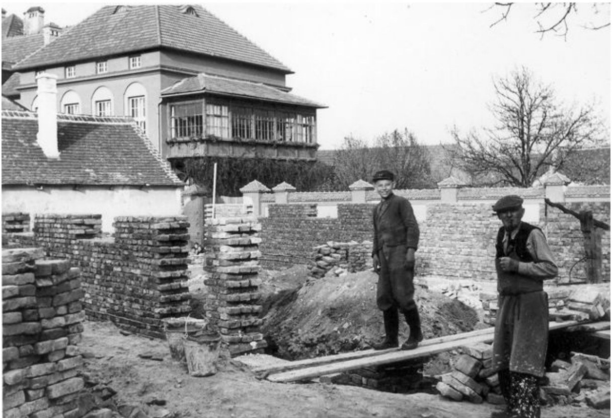
Bild 4, die Baustelle, im Hintergrund das Kloster St. Martha, 1953.
