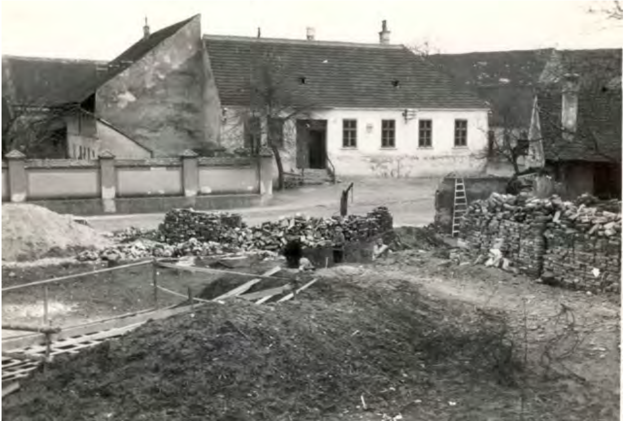
Bild 3, die Baustelle, im Hintergrund das ehem. Gemeinde-/Postamt, 1953, in welchem sich heute das „Otto Berger Heimatmuseum“ befindet.
