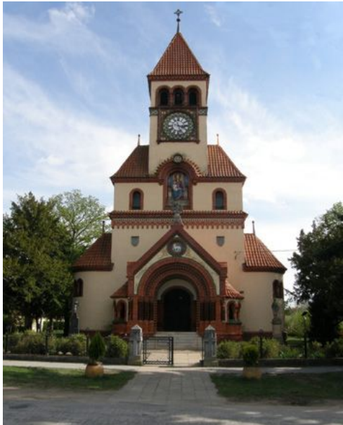
Abb. 6 Pfarrkirche „Hl. Erzengel Michael“ in Rampersdorf [Ladná].
