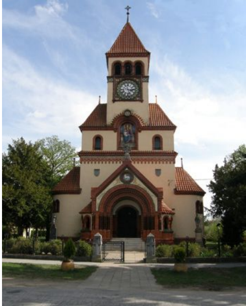
Abb. 6 Pfarrkirche „Hl. Erzengel Michael“ in Rampersdorf [Ladná].
