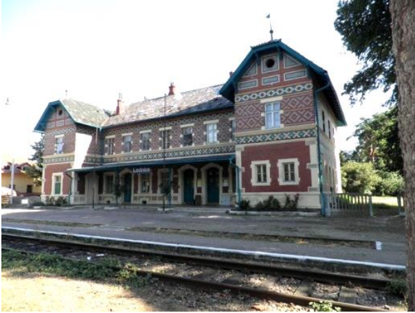
Abb. 3 Bahnhofsgebäude in Eisgrub [Lednice].
