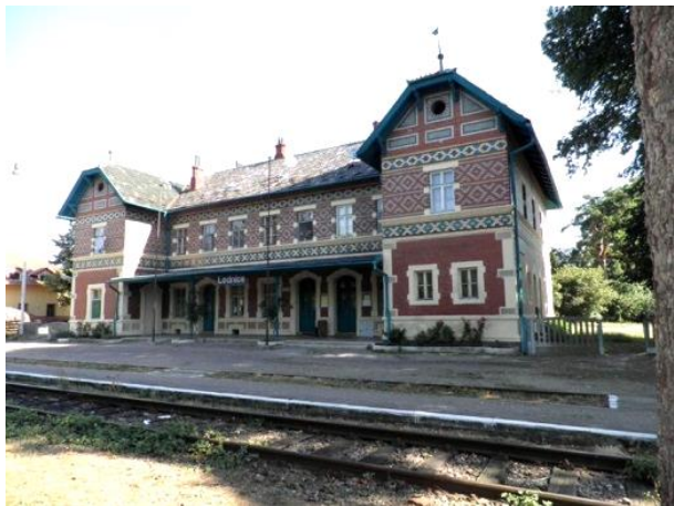
Abb. 3 Bahnhofsgebäude in Eisgrub [Lednice].
