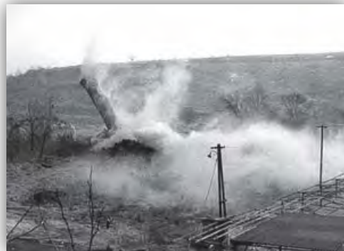
Abb. 7, Abbruch der Langer Ziegelei um 1975, Bild 2.
