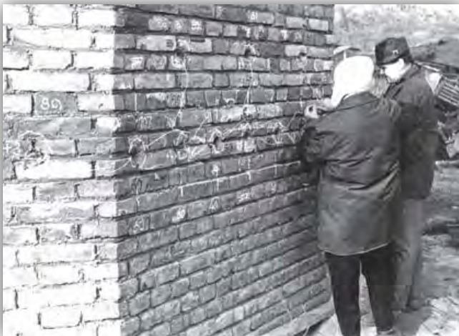
Abb. 6, Abbruch der Langer Ziegelei um 1975, Bild 1.
