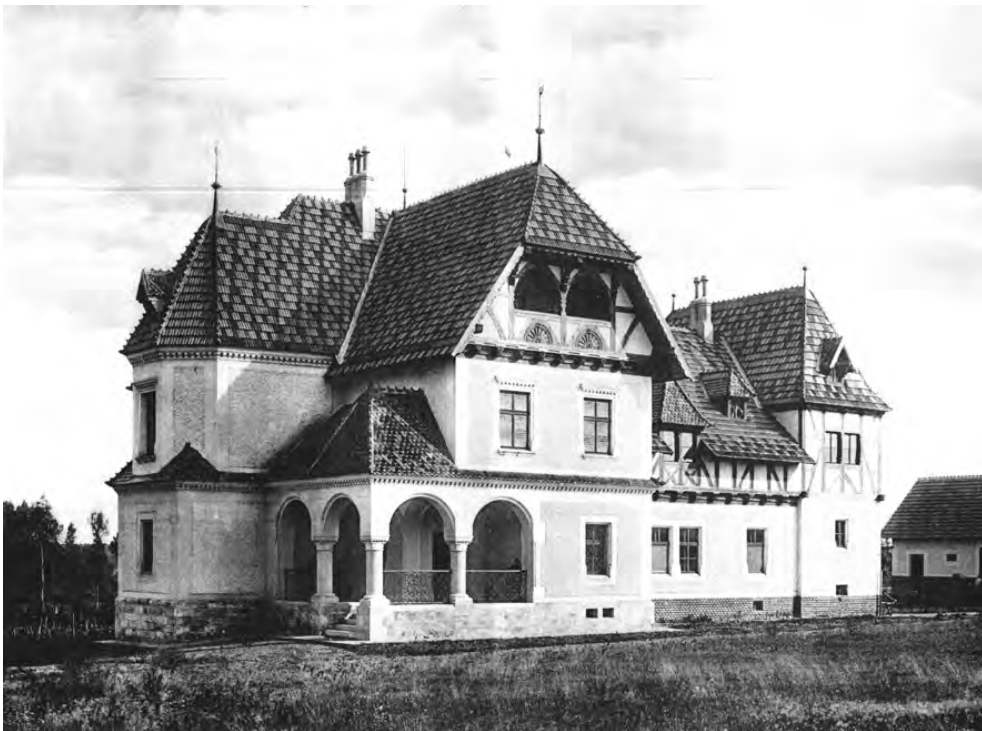
Abb. 3, Jagdhaus in Landshut (Westansicht) / Myslivina v Lanžhotě (západní pohled).
