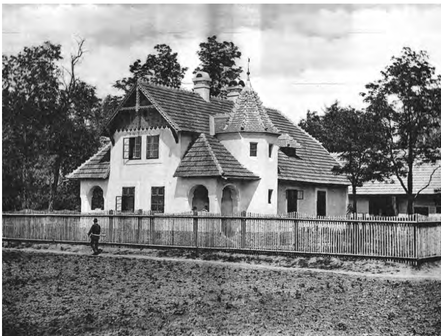
Abb. 5, Doppelhegerhaus im Unterwald bei Eisgrub / Hájenka »Lubeš« mezi Břeclavi a Lednici.
