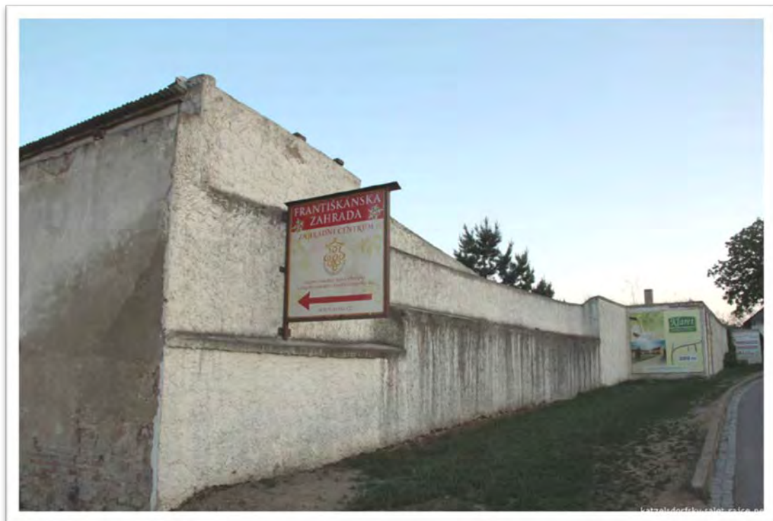
Teil der Kirchengrundmauer im neu eröffneten Franziskanergarten.
