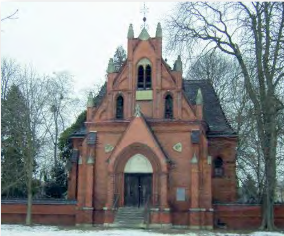
Das Tahara-Haus, das Franz Neumann jun. 1892 im Auftrag der Familie Kuffner beim jüdischen Friedhof Lundenburg erbaute. Foto: T. Walzer, mit freundlicher Genehmigung.
