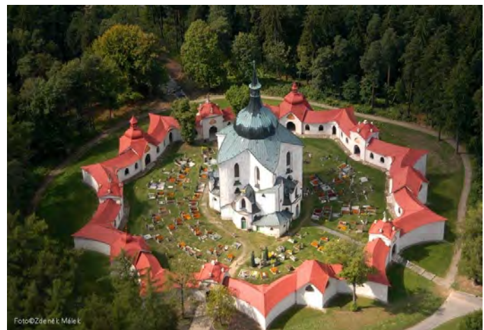
Wallfahrtskirche auf dem Grünen Berg in Žďár nad Sázavou
