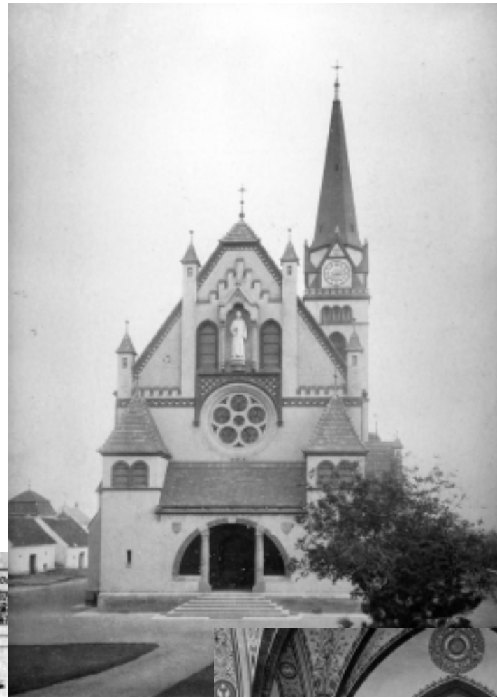
Die neue Pfarrkirche
