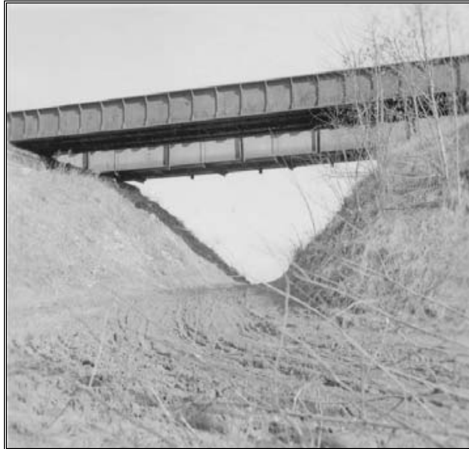
Kapellenbrücke um 1950 2 Eisenkonstruktionen als Ersatzbrücken für die 1945 gesprengte Brücke, das Sprenggut bildete einen Hügel unter der Brücke
