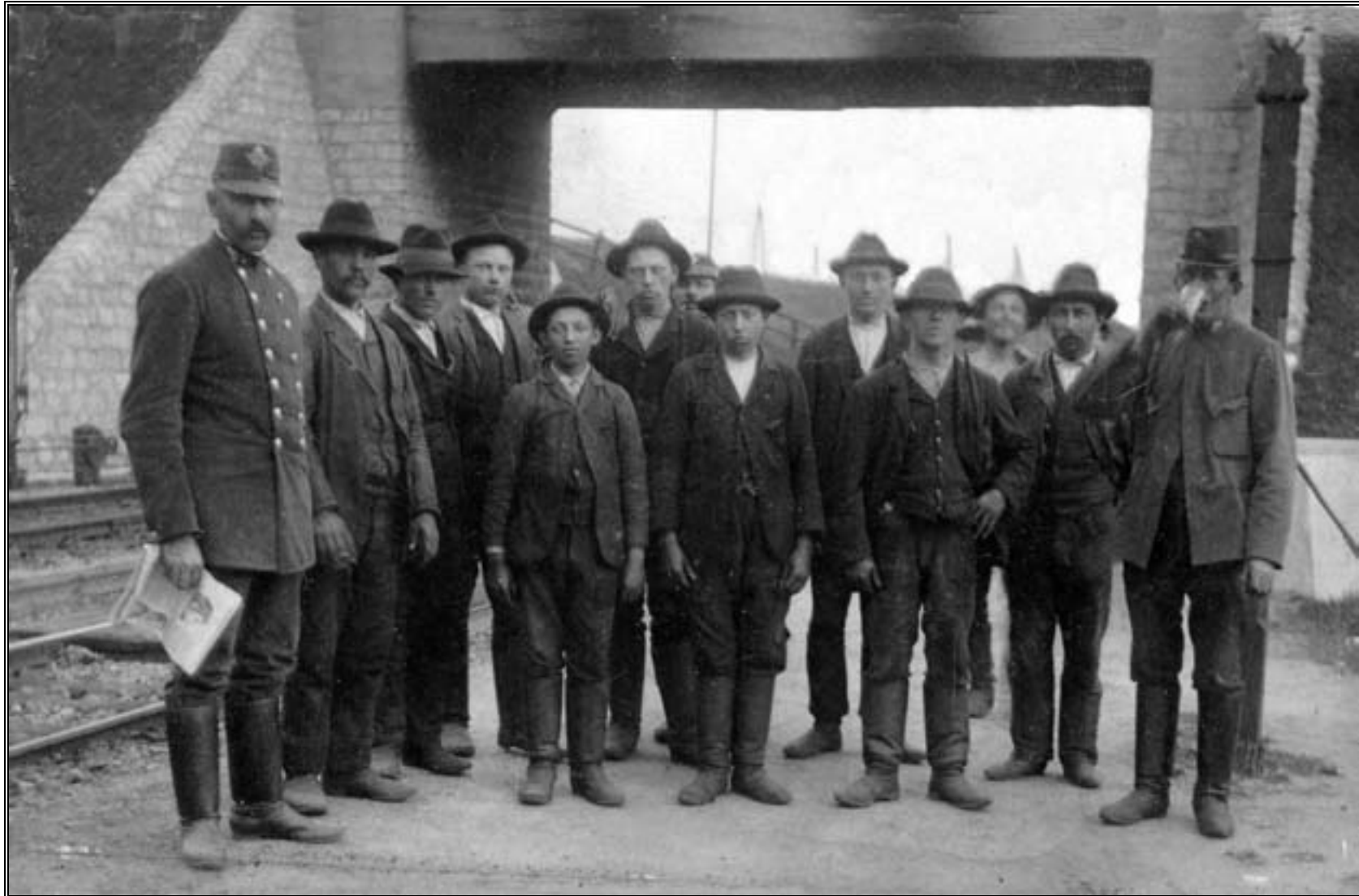
Oberbauarbeiter (?) vor der 1905 errichteten Beton-Bahnhofsbrücke. Die Bahnbrücke wurde 1945 gesprengt und bis 1970/71 durch eine Holzbrücke ersetzt.
