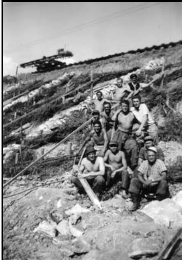
Reparatur des abgerutschten Bahndamms, 1958 Smutny Leo, Bednarik Franz („August“)
