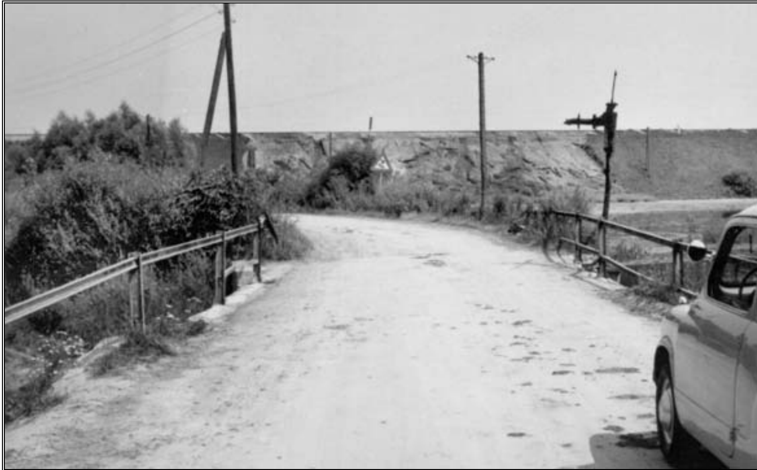
Lundenburgerstraße, dahinter der 1958 abgerutschte Bahndamm, rechts an der Brücke die Wasserentnahme aus dem Hamelbach
