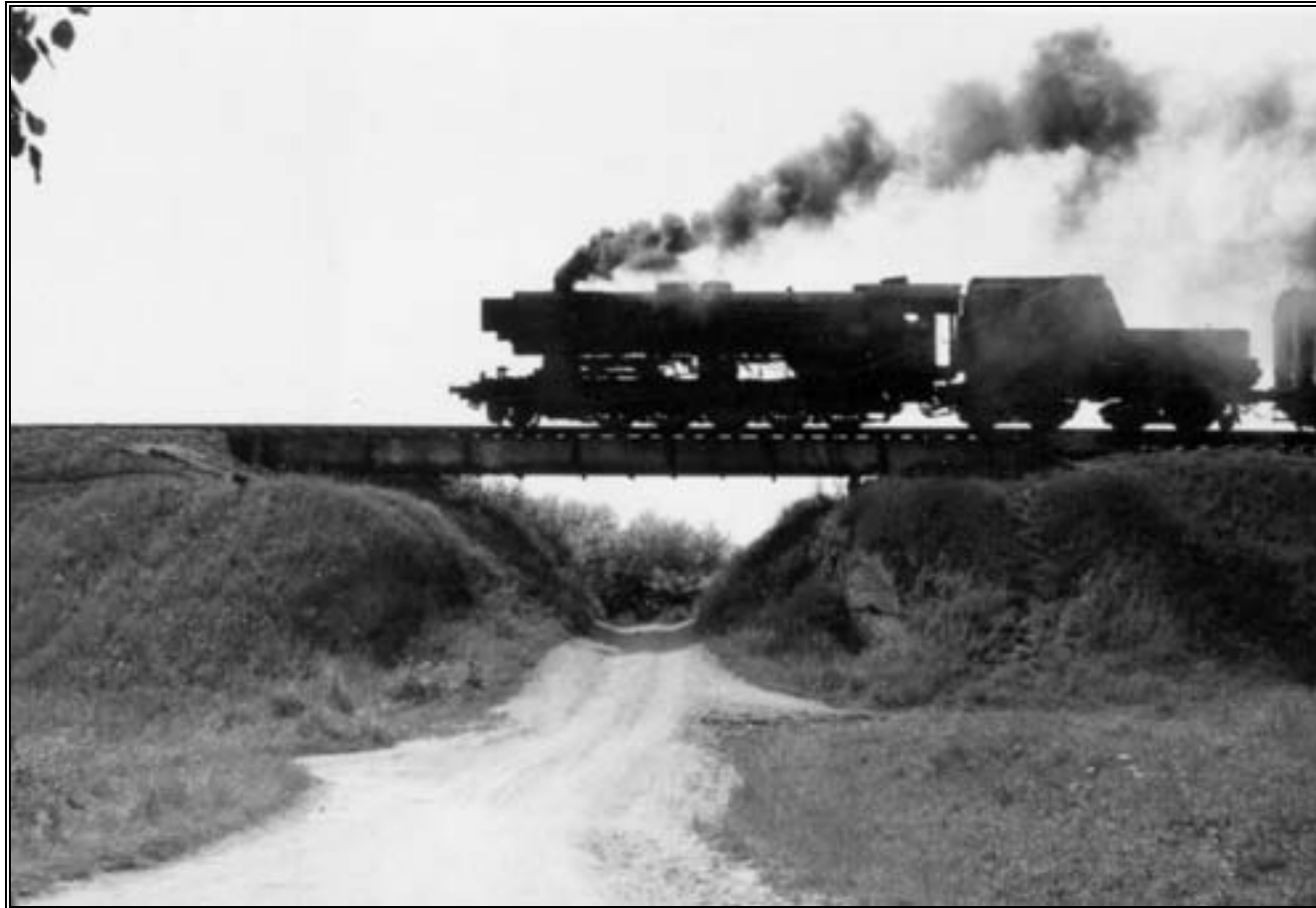
52er Lok auf der provisorisch wiedererrichteten Brücke bei der Kapelle. Gut zu erkennen, der durch das Sprenggut entstandene Hügel unter der Brücke.
